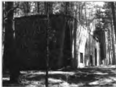
Stanowisko nr 2 baterii.
