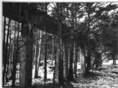
Filary żelbetowej estakady.
